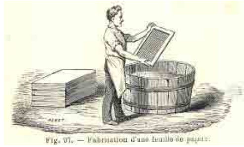
Fig. 57. — Fabrication d'une feuille de papier:
